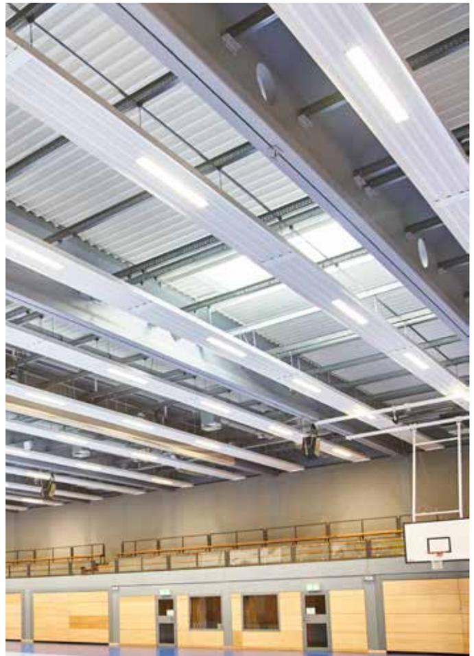
Ballwurfsichere Systemeinbauleuchte, integriert in Deckenstrahlplatte HB 150 ECO EVO Plus
