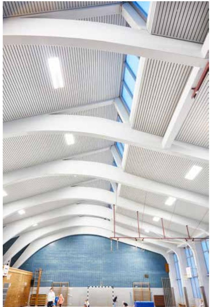
Ballwurfsichere Systemeinbauleuchte, integriert in Paneeldeckenstrahlungsheizung A-85/S-85
