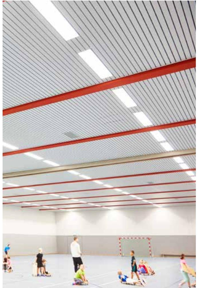
Ballwurfsichere Systemeinbauleuchte, integriert in Paneeldeckenstrahlungsheizung A-85/S-85
