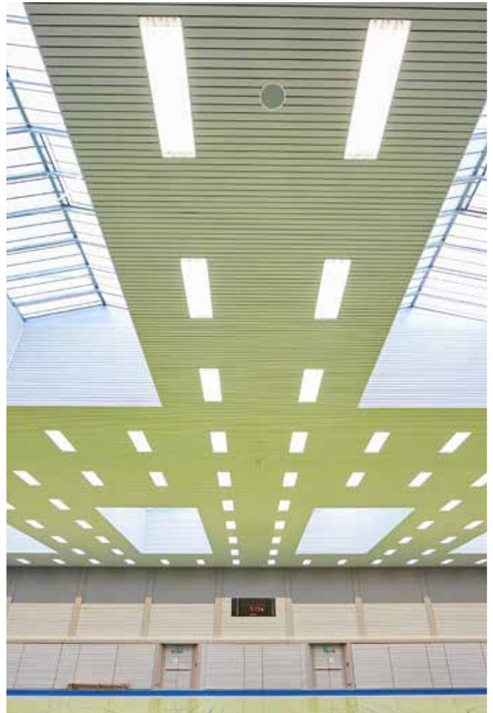
Ballwurfsichere Systemeinbauleuchte, integriert in Paneeldeckenstrahlungsheizung A-85/S-85
