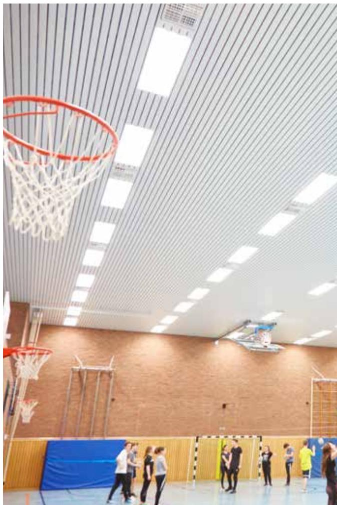
Ballwurfsichere Systemeinbauleuchte, integriert in Paneeldeckenstrahlungsheizung A-85/S-85
